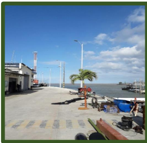
Lámparas y reflectores instalados en postes de fibra de vidrio
