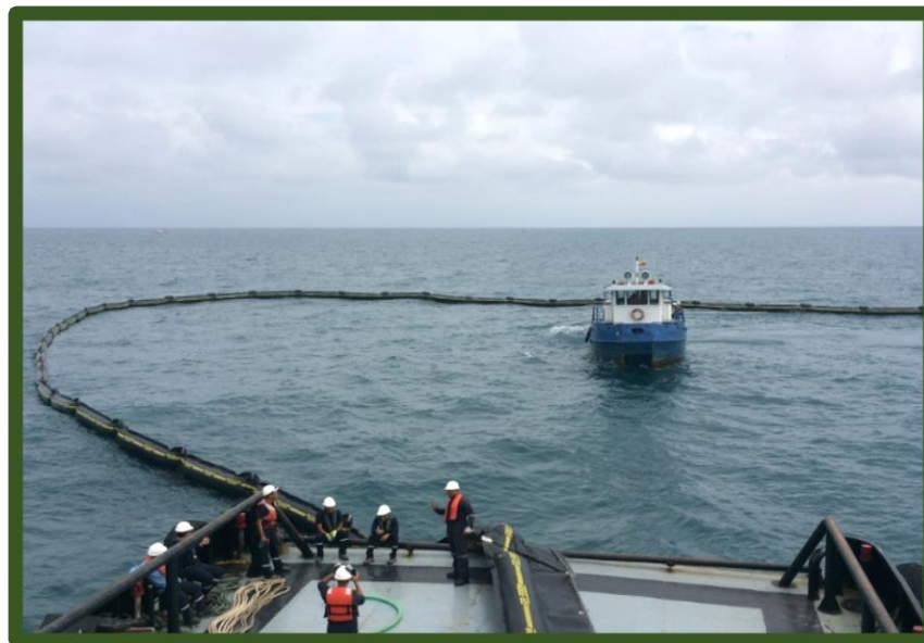
Culminación del despliegue de barreras flotantes
