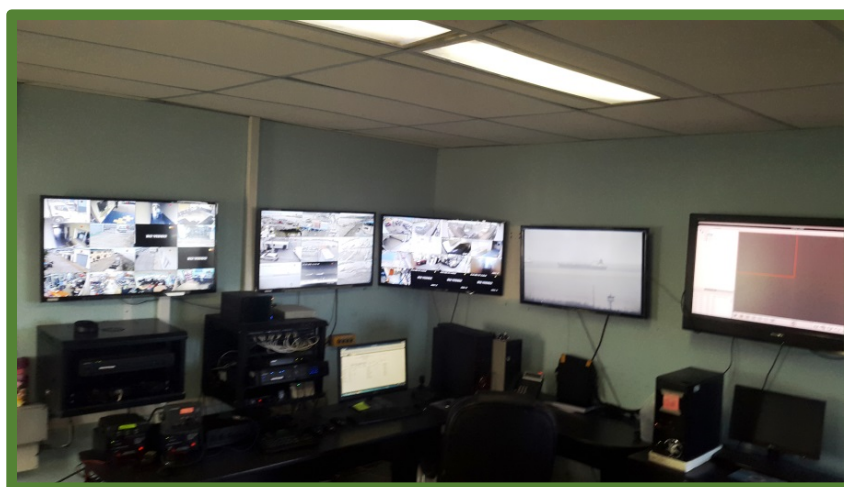
Sala de Control del Sistema Circuito cerrado de televisión
