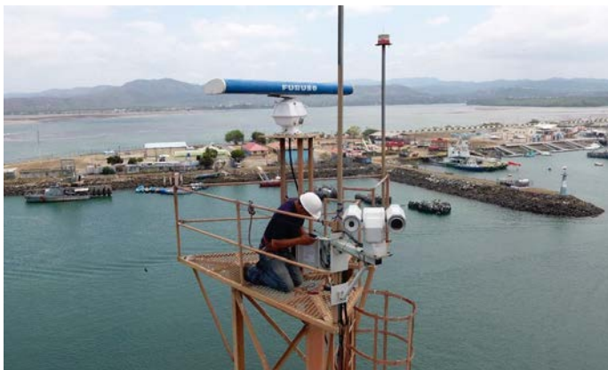
Mantenimiento para la recuperación de la Cámara térmica
