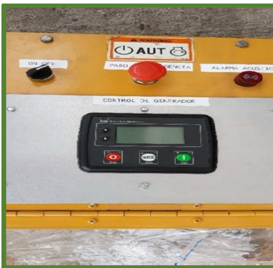
Panel de control de generador de energía R/Venus
