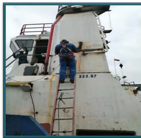
Reparación del remolcador Marte
