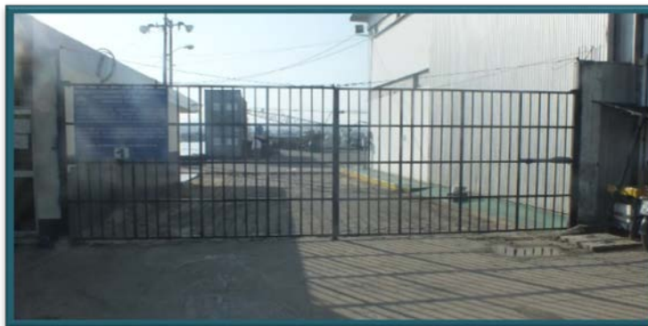
Portón de acceso vehicular a la instalación portuaria
