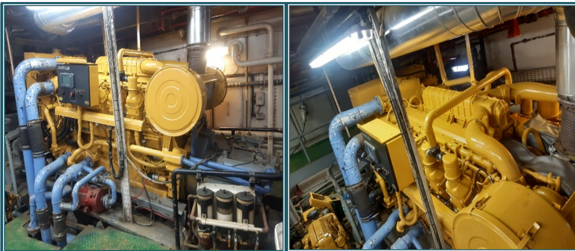
Máquina principal de babor y estribor reparadas
