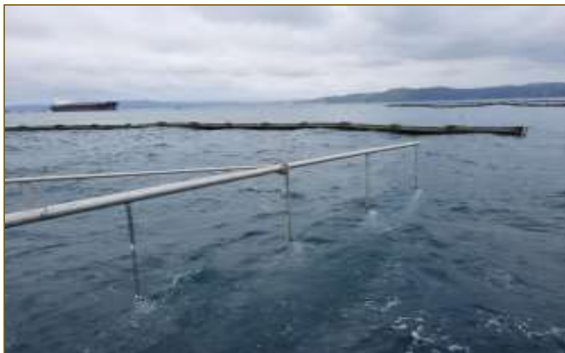
Instalación de barreras flotantes
