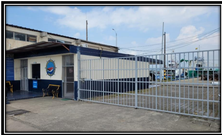
Fotografía No. 2 Ingreso vehicular – Portón
